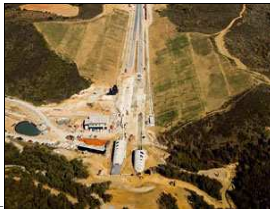
Obr. č.10 – Ražba tunelu Perthus
