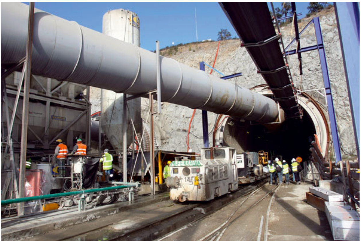
Průběh výstavby tunelu
