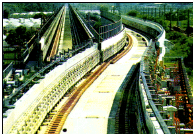
Obr. 7.: Výhybka v km 1,3 trati Miyazaki
