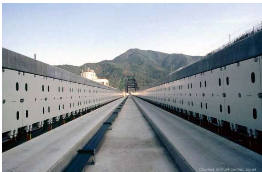
Ilustrace 8: Detail jízdní dráhy (zdroj: http://www.magnetbahnforum.de )
