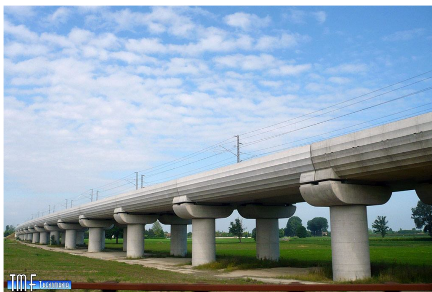
jeden z viaduktů u Modeny
