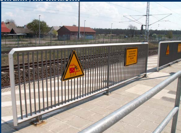
Ochranné mříže na nástupišti ve stanici Paulinenaue [1]
