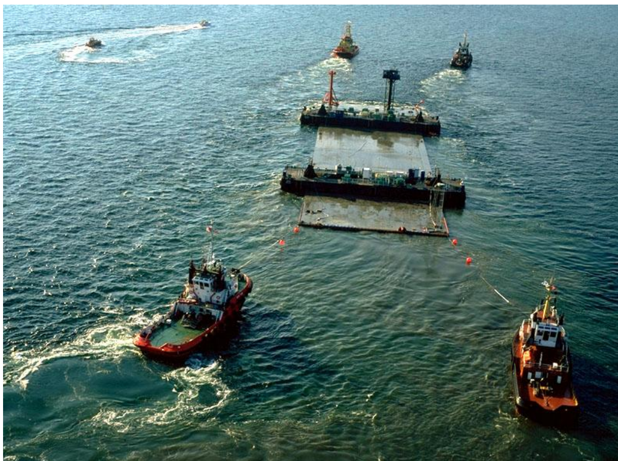
Obrázek 6 - Doprava segmentu na místo uložení [5]
