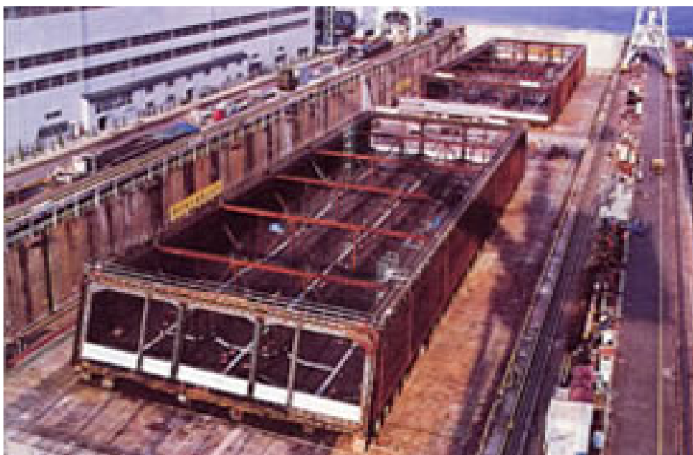
Obrázek 4 - Stavba segmentu tunelu v suchém doku [1]
