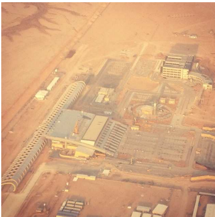
Obrázek č. 8 Rozestavěná železniční stanice ve městě Riyadh, leden 2015
